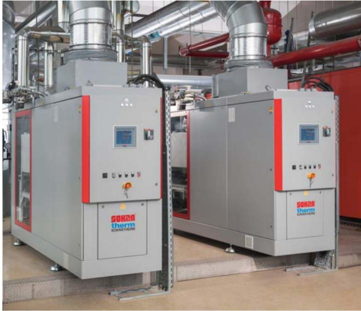
Moderne Blockheizkraftwerke sind eine saubere und oftmals günstige Alternative zur Strom- und Wärmeerzeugung. Hier die BHKW-Kompaktmodule GG 132 und GG 100 von Sokratherm.
