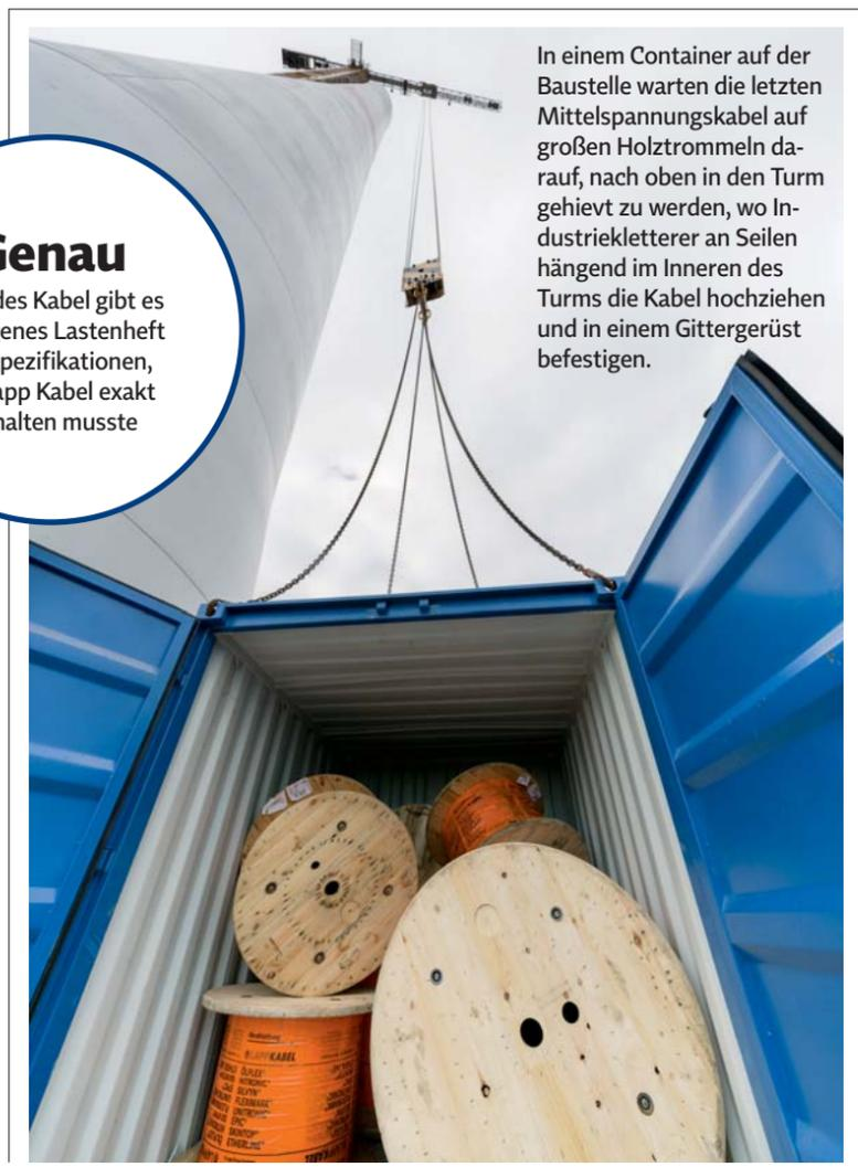
In einem Container auf der Baustelle warten die letzten Mittelspannungskabel auf großen Holztrommeln darauf, nach oben in den Turm gehievt zu werden, wo Industriekletterer an Seilen hängend im Inneren des Turms die Kabel hochziehen und in einem Gittergerüst befestigen.
